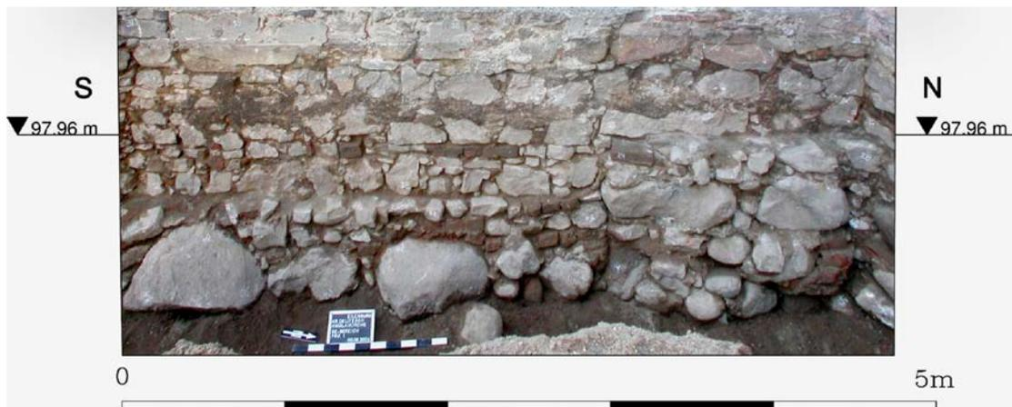
Abb. 2. Entzerrtes Orthofoto einer Fundamentmauer.
