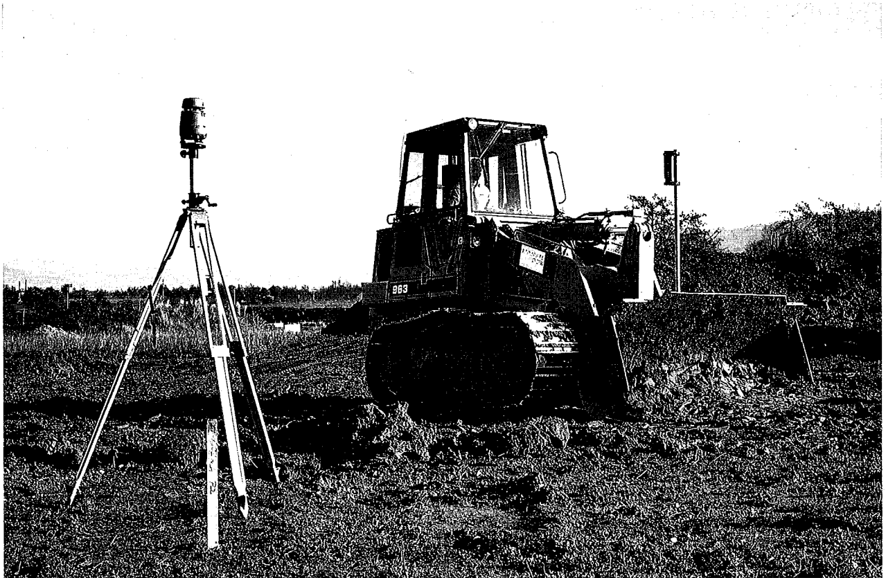
10 d Rotationslaser, der Sensor ist auf die Schaufel der Planierdrape montiert.
